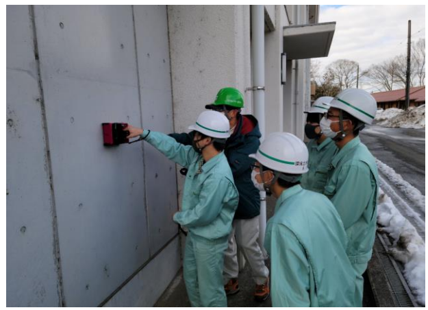
コンクリート調査(鉄筋探査)
