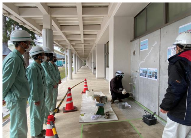
コンクリート補修工事(ひび割れ注入)の見学
