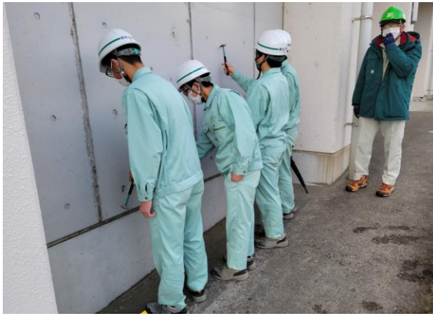
コンクリート調査(打音調査)
