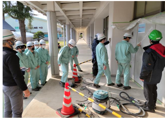
コンクリート補修工事の見学 (ひび割れ注入した2日後の処理作業)
