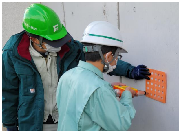
コンクリート調査(シュミットハンマー試験)
