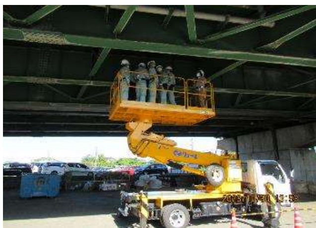
高所作業車によるコンクリート調査
