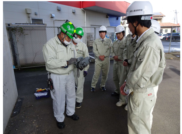
コンクリート調査 (RCLレーダーによる鉄筋探査の説明)
