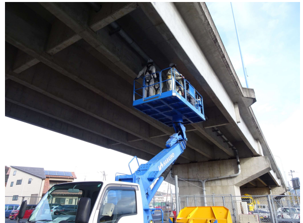
高所作業車によるコンクリート調査
