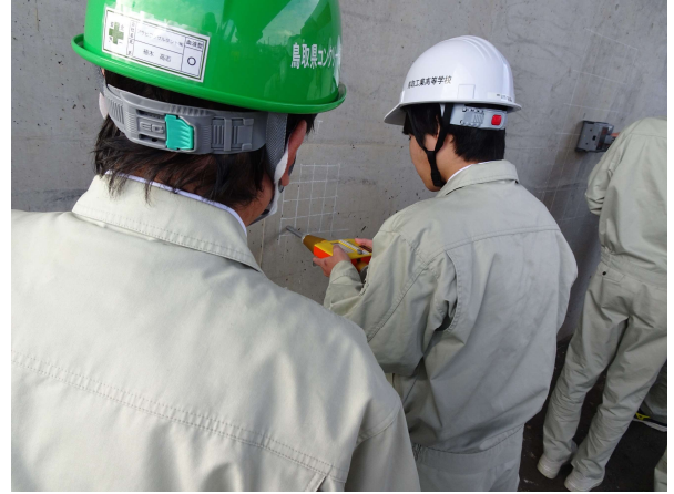
コンクリート調査 (シュミットハンマーの説明)
