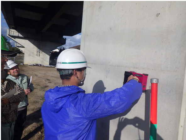
コンクリート調査 (RCレーダーによる鉄筋探査)
