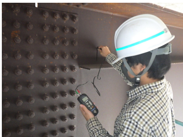
高所作業車による調査 (鋼橋桁の板厚測定)
