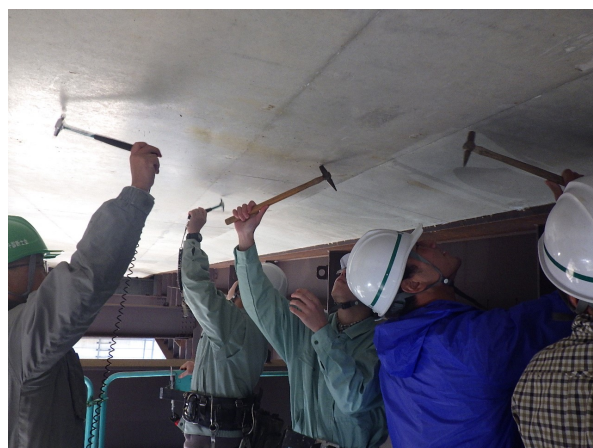
高所作業車による調査 (インフラ維持管理の基礎)
