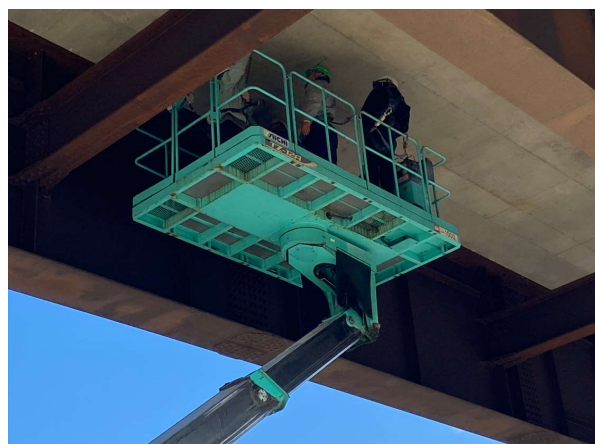
高所作業車による調査
