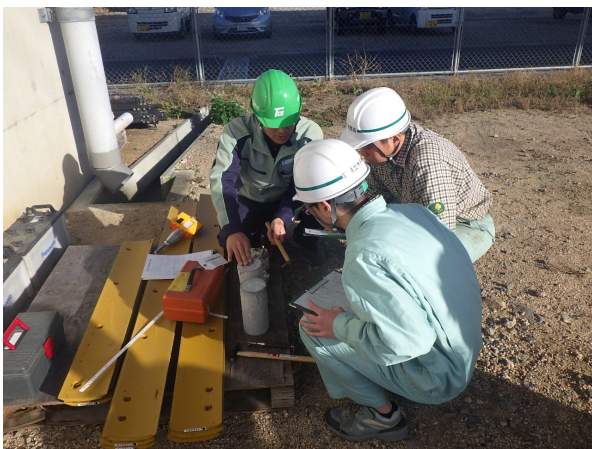
コンクリート調査 (空洞のある不良コンクリート塊の打音調査)
