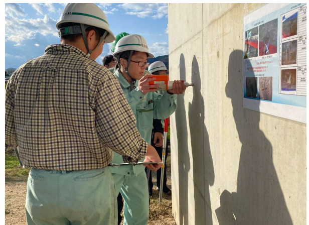
コンクリート調査 (シュミットハンマーによるコンクリート強度推定)
