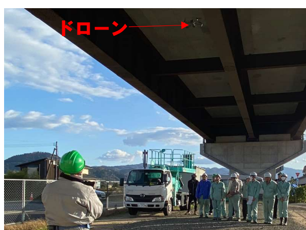
コンクリート調査 (ドローン撮影画像のリアルタイム地上確認)
