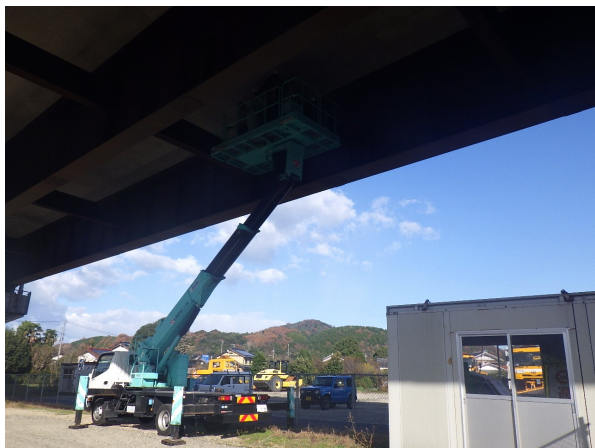
高所作業車による調査
