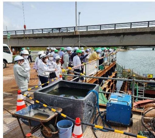
仮締切の見学状況(2)
