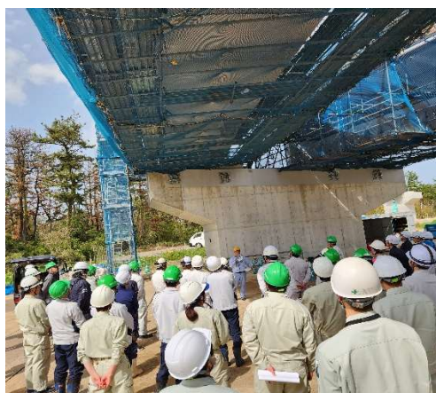
橋梁下にて概要説明(1)
