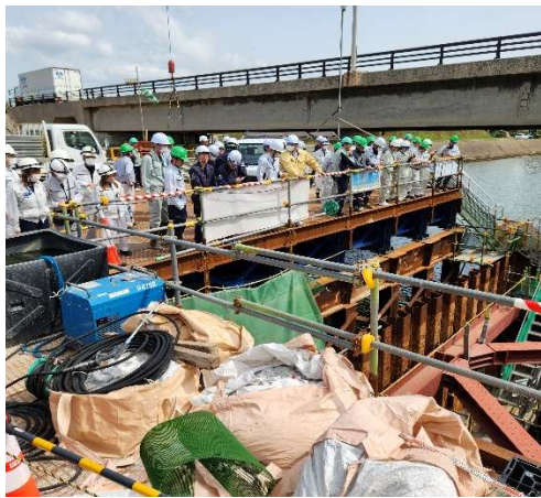
仮締切の見学状況(1)
