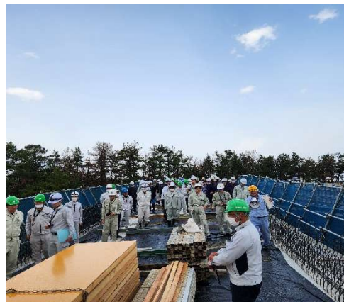
壁高欄配筋状況を見学
