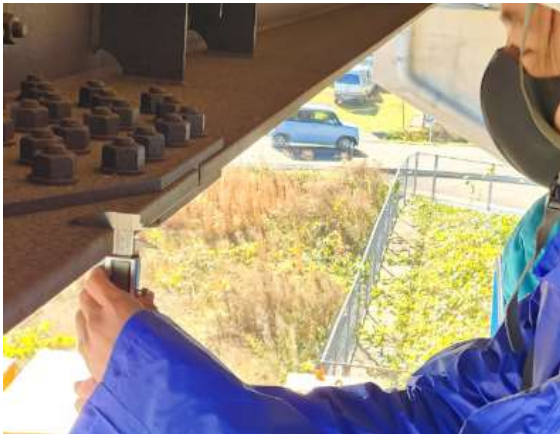
高所作業車によるコンクリート調査 (ノギスによる鋼橋桁の板厚測定)
