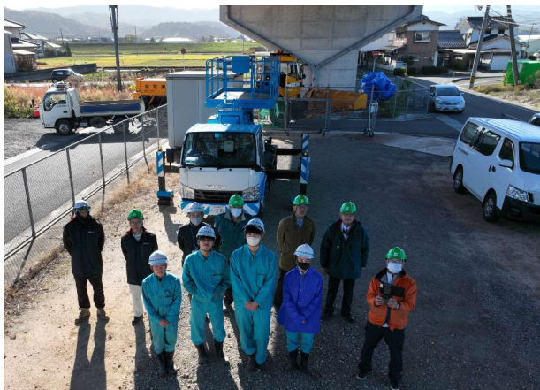
集合写真 (ドローンから撮影した実習現場)
