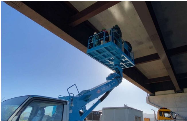
高所作業車によるコンクリート調査
