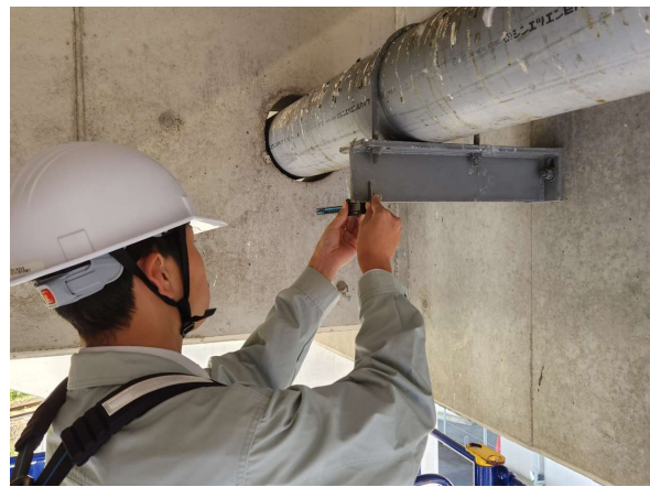
高所作業車によるコンクリート調査 (超音波厚さ計による鋼版の板厚測定)
