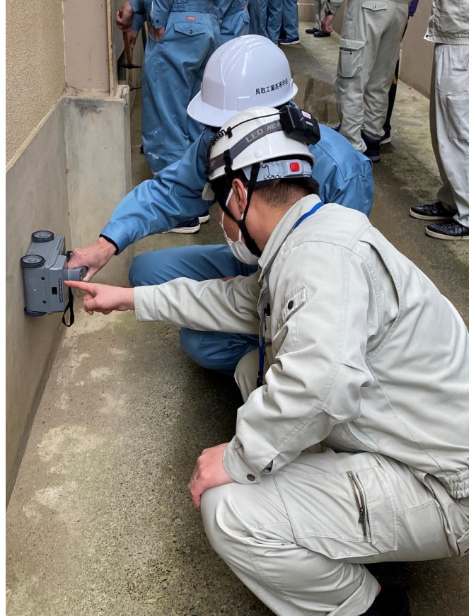
コンクリート調査 (RCLレーダーによる鉄筋探査)
