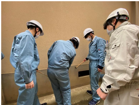
コンクリート調査 (打音調査)
