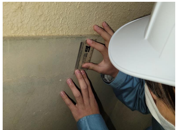
コンクリート調査 (クラックスケールによるひび割れ幅測定)
