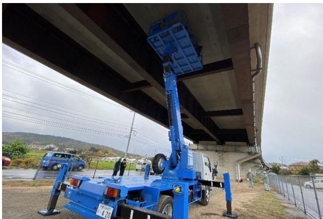
高所作業車によるコンクリート調査
