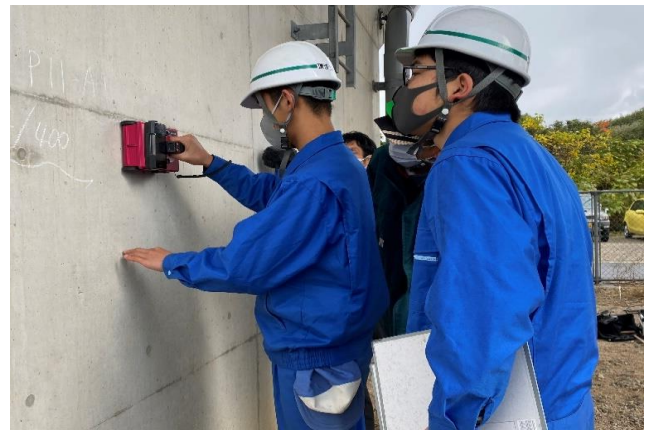
コンクリート調査 (RCLレーダーによる鉄筋探索)
