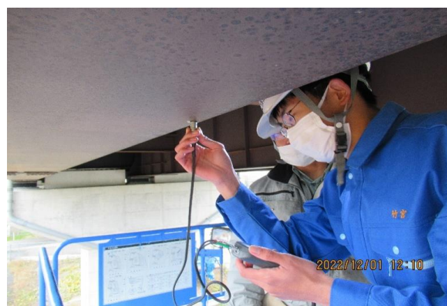
高所作業車によるコンクリート調査 (超音波厚さ計による鋼橋桁の板厚測定)
