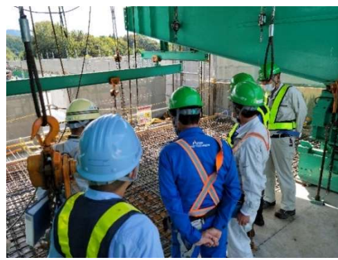
配筋状況の確認 (川関橋)
