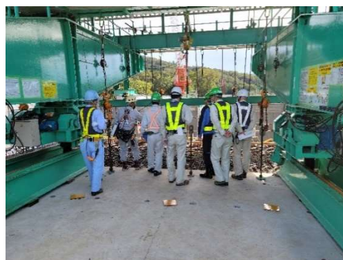
移動支保工付近 (川関橋)
