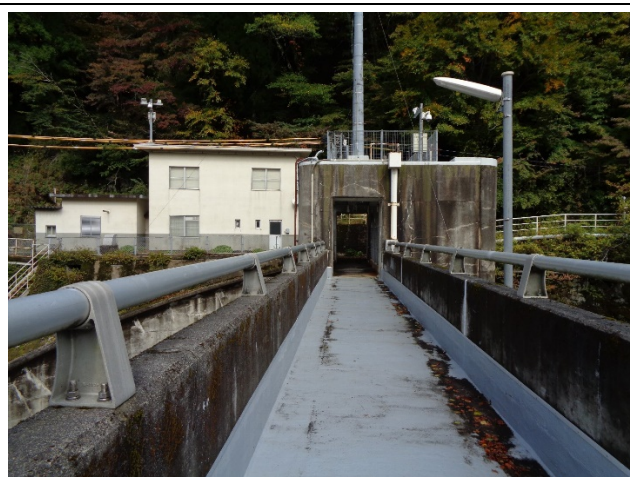
三滝ダム 堤頂通路
