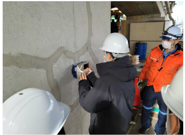
コンクリート調査(鉄筋探査)
