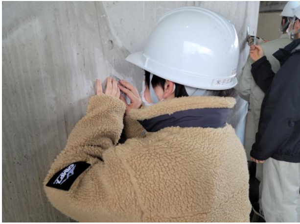
コンクリート調査(ひび割れ幅の計測)
