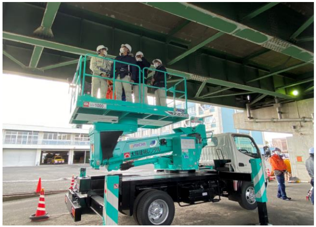
高所作業車による橋梁点検
