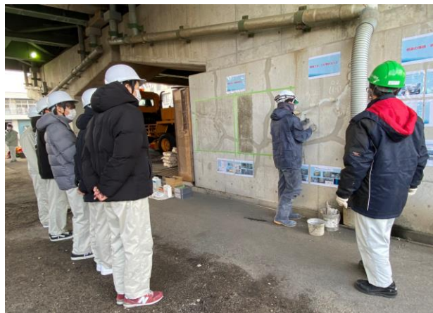
コンクリート補修工事の見学
