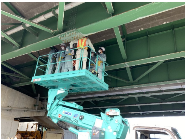
高所作業車による模擬点検
