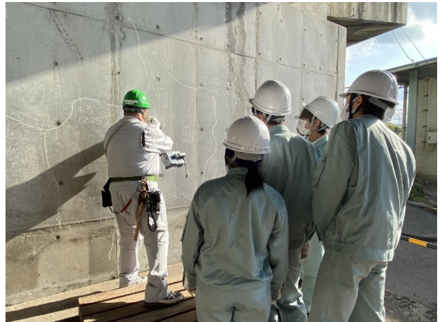
コンクリート非破壊試験
