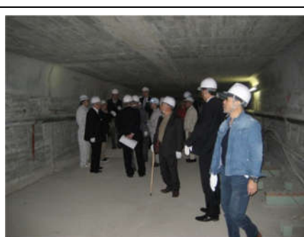
浦戸大橋 PC 箱桁内部
