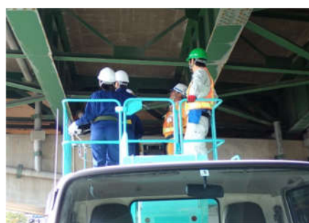
高所作業車による近接目視点検
