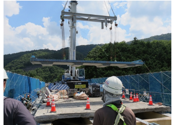
PC 床版設置
