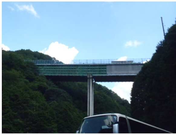
工事箇所:坂尻橋
