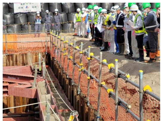
仮締切・底版配筋の見学状況（2）
