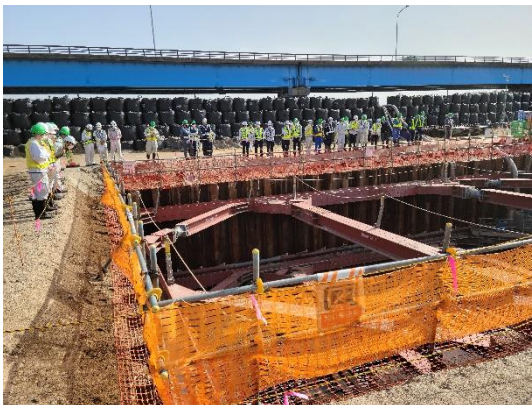
仮締切・底版配筋の見学状況（1）
