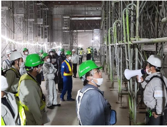
建物内部の施工状況説明
