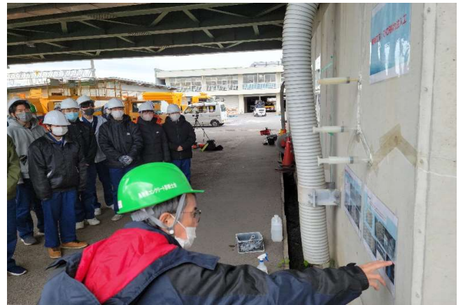
コンクリート補修工事の見学 (ひび割れ注入)
