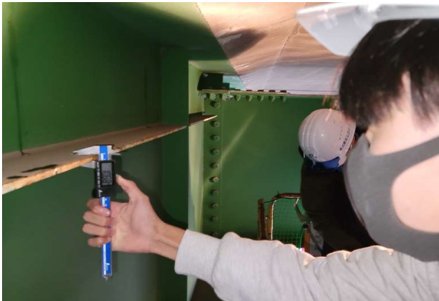
高所作業車によるコンクリート調査 (ノギスによる鋼橋桁の板厚測定)
